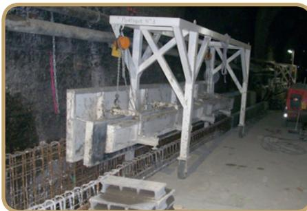
*Bétonnage des caniveaux*
