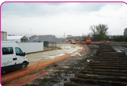
*Mise en place des futures voies de triage (à droite) et tas de ballast (au fond)*
