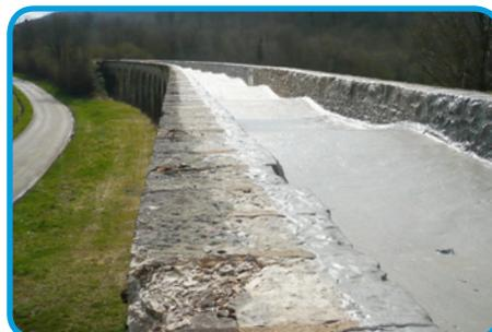
Etanchéité du viaduc de Ramasse
